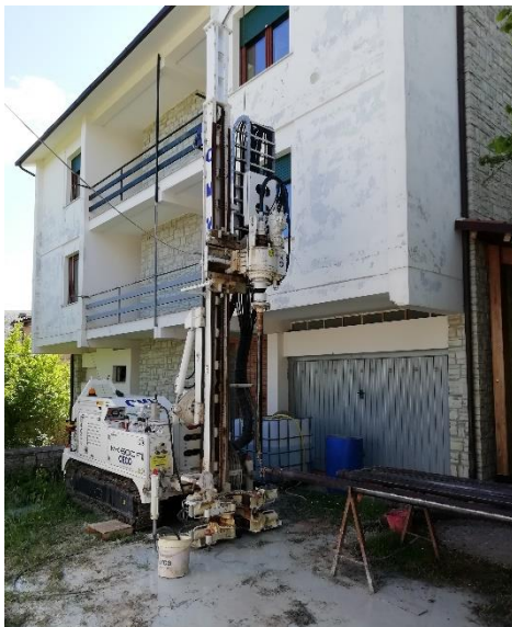
Foto 8 - Esecuzione sondaggio geognostico S1
